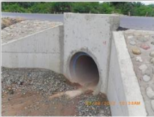
Foto 14. Alcantarillas terminadas.
