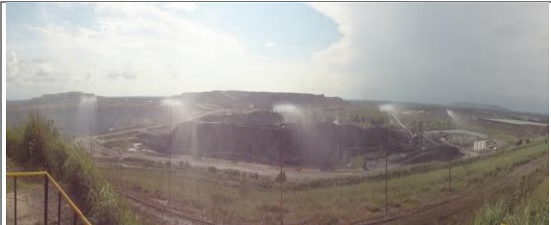
Foto 12. Operación del sistema de microaspersión (cortinas de agua) instalados en el botadero aledaño al área de acopio de carbón.
