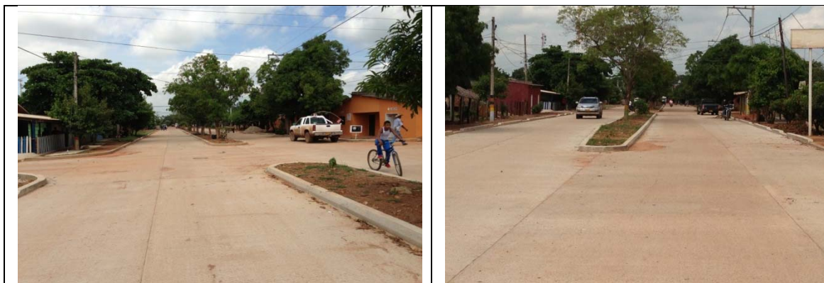
Foto 18. Vías urbanas pavimentadas en el corregimiento de la Loma, Municipio del Paso – Cesar.
