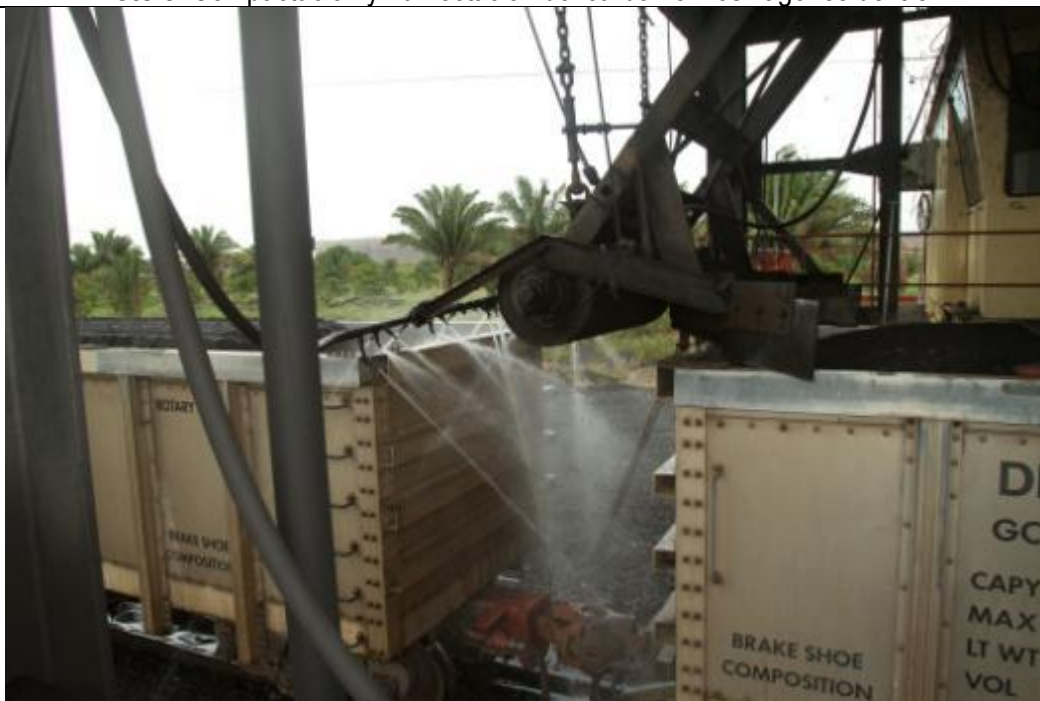
Foto 6. Sistema de lavado de vagones antes de salir hacia Ciénaga.
